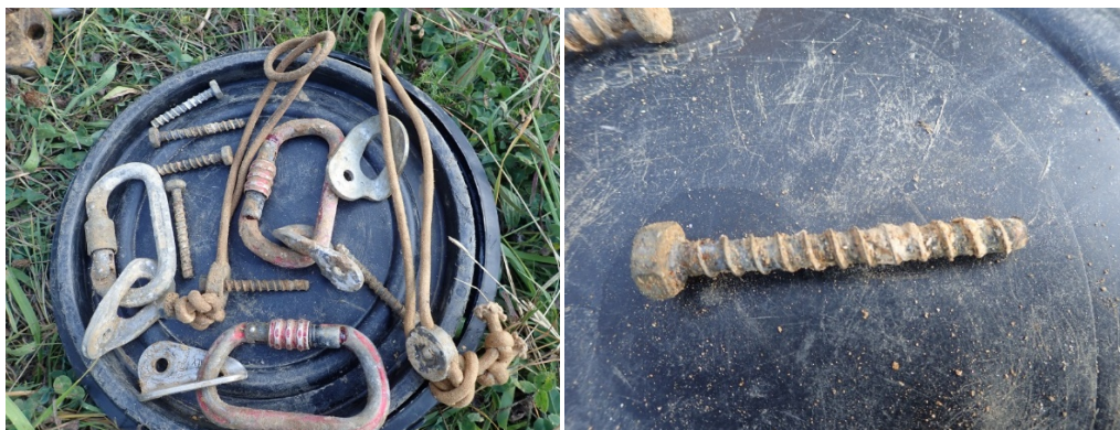
Diferentes muestras de corrosión
